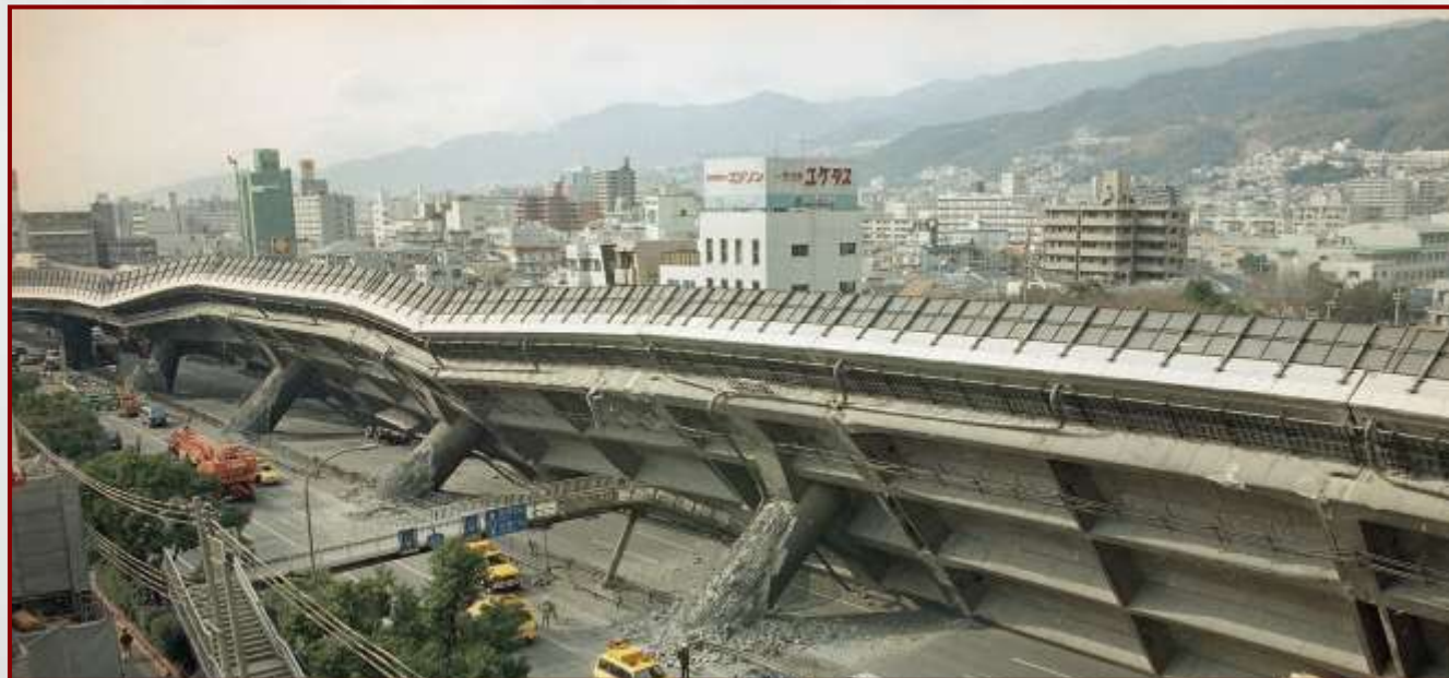
Ten 500-metrowy fragment estakady w Kobe runął podczas trzęsienia ziemi
