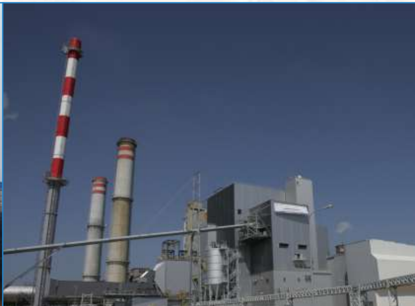
Elektrownia węglowa Konin, spalająca węgiel brunatny i biomasę Elektrownia powstała w 1958 roku.
