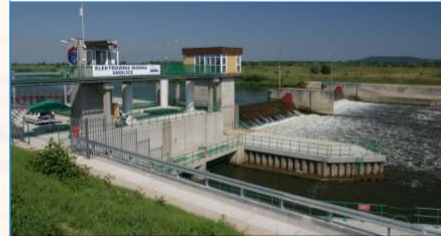
Elektrownia przepływowa Smolice Elektrownia z dwa turbozespołami o łącznej mocy 2 MW.
