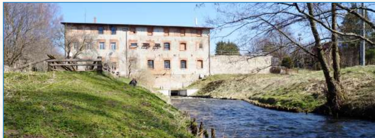
Elektrownia wodna Struga na Słupi działająca od 1896 roku Najstarsza w Polsce (jedna z najstarszych na świecie) hydroelektrowni.
