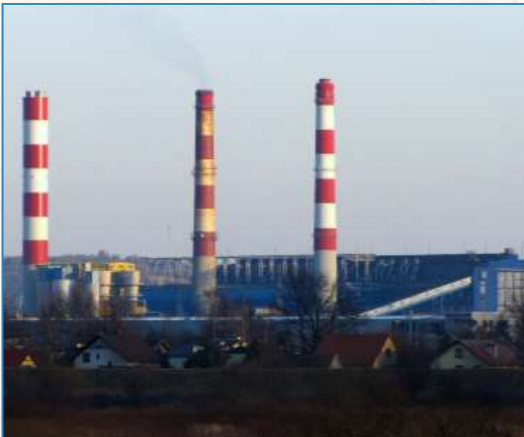
Elektrownia ciepła Skawina, spalająca węgiel kamienny Elektrownia powstała w latach 1957-1961 roku.
