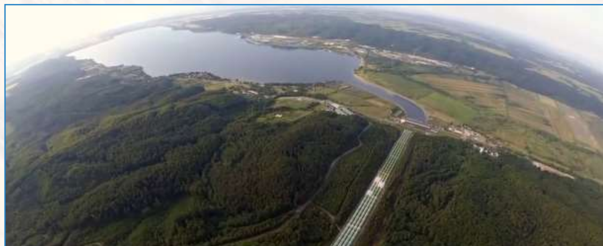
Elektrownia wodna Żarnowiec w miejscowości Czymanowo Największa w Polsce hydroelektrownia, a dokładniej elektrownia szczytowo-pompowa o mocy 716 MW, wybudowana w latach 1973-1983, położona pomiędzy zbiornikiem wodnym Czymanowo (górny zbiornik) a Jeziorem Żarnowieckim (dolny zbiornik), wykorzystującą cztery jednakowe hydrozespoły odwracalne.
