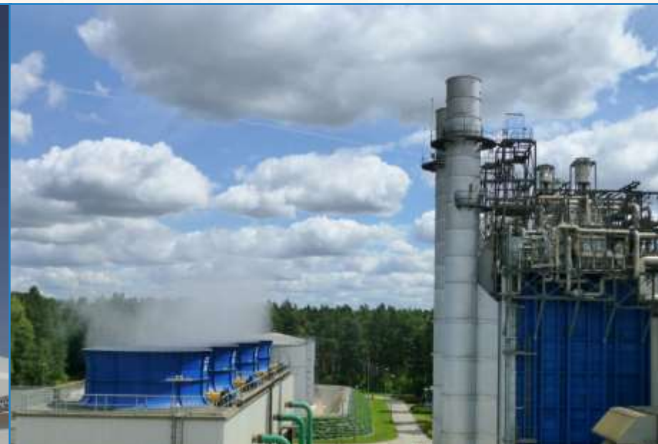
Elektrownia ciepła Skawina, spalająca węgiel kamienny Elektrownia powstała w latach 1957-1961 roku.
