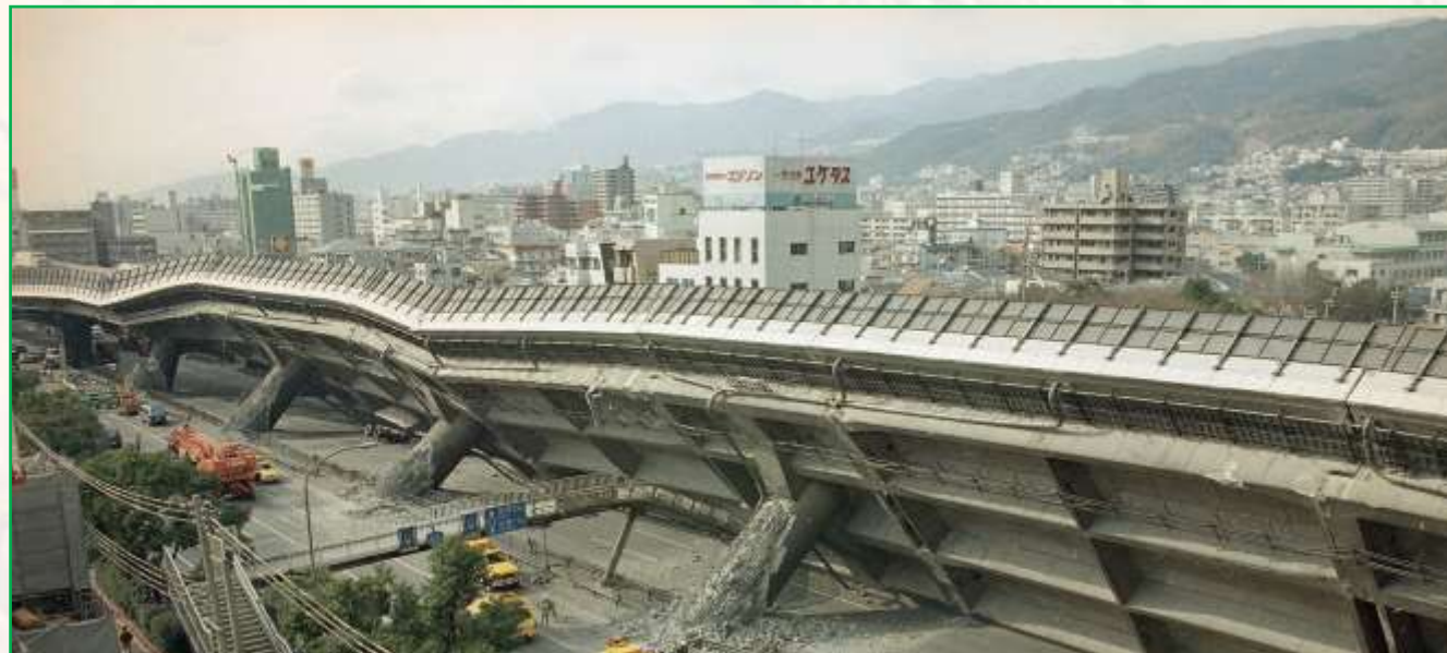
Ten 500-metrowy fragment estakady w Kobe runął podczas trzęsienia ziemi
